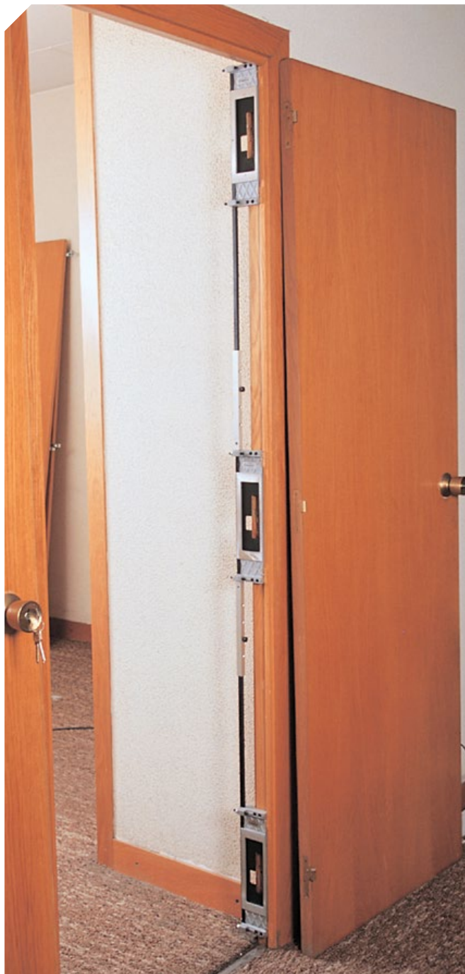
Porte-gabarit A093 à 3 corps, monté en batterie sur le dormant.
