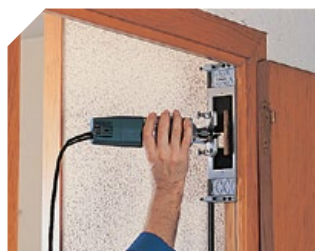
Usinage sur dormant (huisserie) avec modèle A093.
