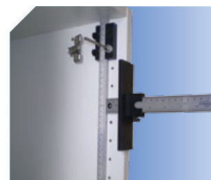
Perçage pour mise en place d'embases de charnières invisibles.
