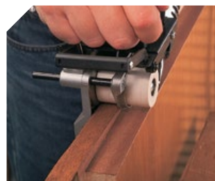
Placage de la face supérieure de la feuillure.
