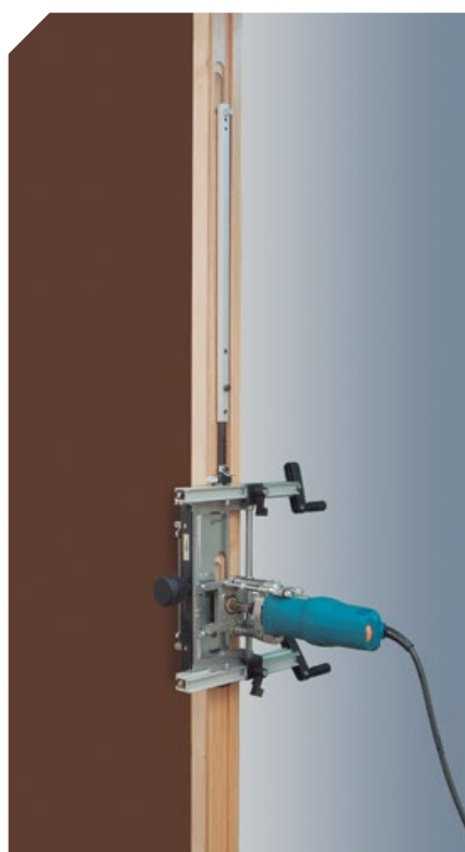
Entaillage de la deuxième paumelle sur le montant.
