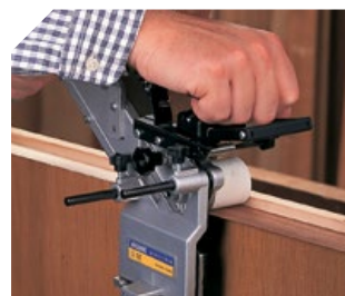
Placage de la face intérieure d'une porte à feuillure.
